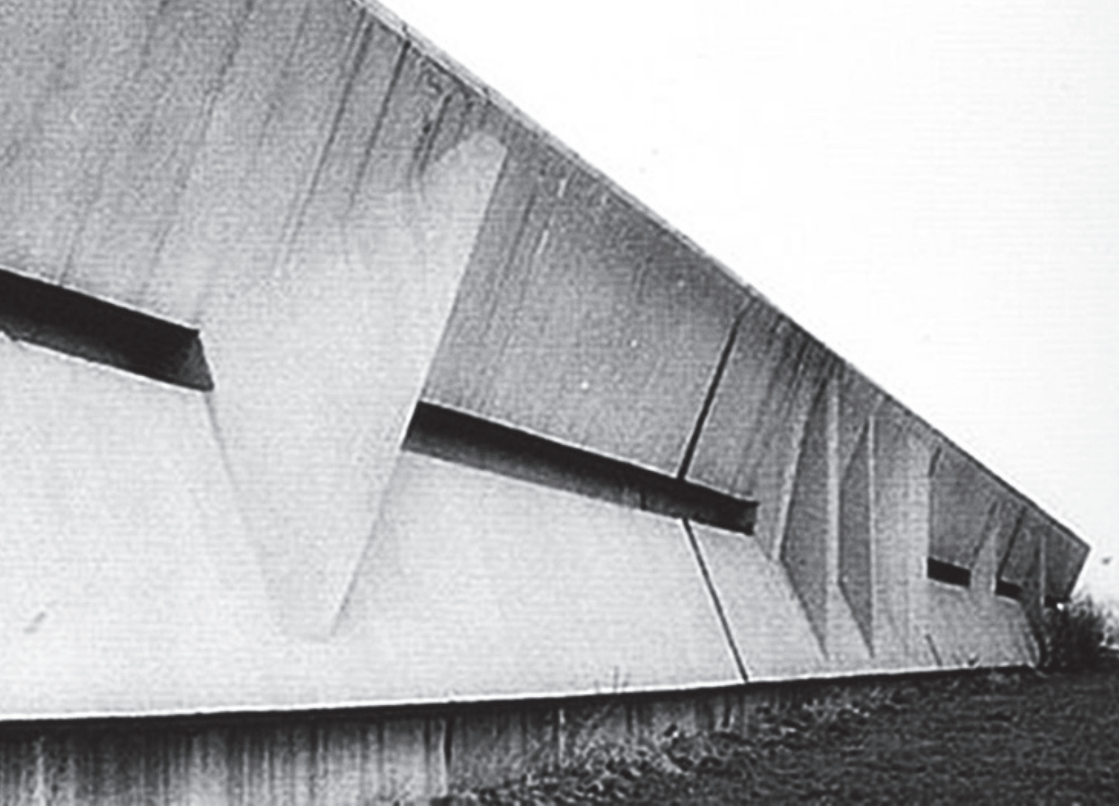
[01] Stanislav Kolíbal; sochařské ztvárnění opěrné zdi; 1968, Praha/Vyšehrad příklad zakomponování uměleckého/sochařského prvku v souvislosti s investicí/výstavbou Nuselského mostu
